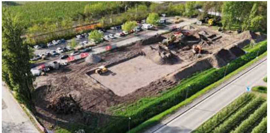
Der neue Recyclinghof entsteht am Branzollerweg
