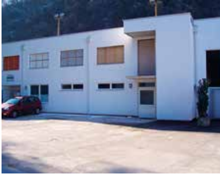
Neue Umkleidekabinen Eisplatz
