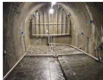
Nuovo tunnel per presa sorgenti
