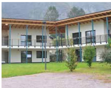
Costruzione alloggi per anziani
