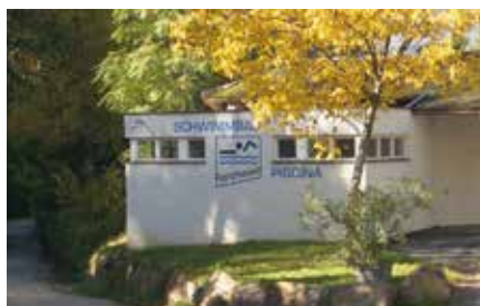
Beim Freibad wurden Lagerräume dazugebaut
