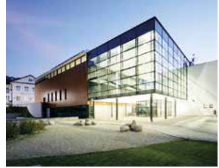
Die Aula Magna mit Turnhallen wurde über das Schulbautenprogramm errichtet
