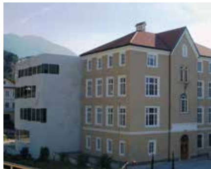
Grundschule saniert und erweitert
