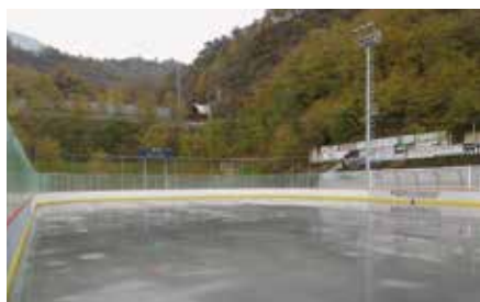
Beide Kunsteisplätze wurden saniert
