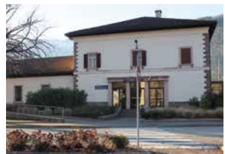
Nuovi sanitari e ristrutturazione esterni presso la stazione
