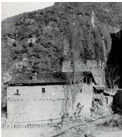
Zur Leiterburg gehörende Gebäude am Fuße des Schlossberges. Rechts im Hintergrund der Turm
