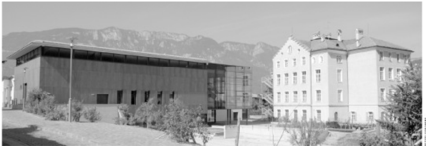
Bei der Aula Magna, den Turnhallen und der Grundschule Auer wurden Verbesserungsarbeiten durchgeführt.
