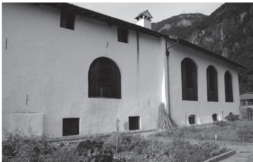
Happacherhof Auer: Beginn der Umbauarbeiten im Sommer 2012
